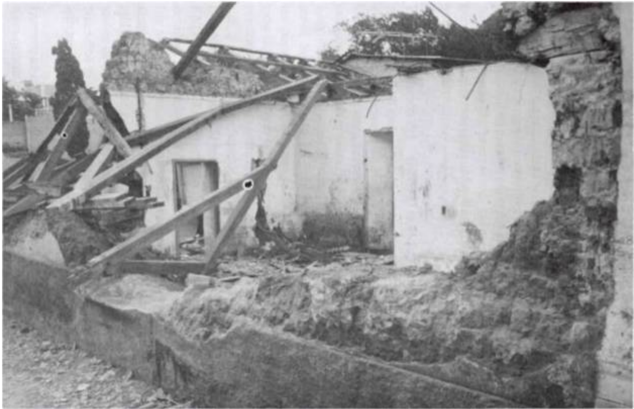
Destrozos en la 1ra Ave. De Comayagüela, hoy Avenida de México lo que quedó una vez bajadas las aguas torrenciales.
