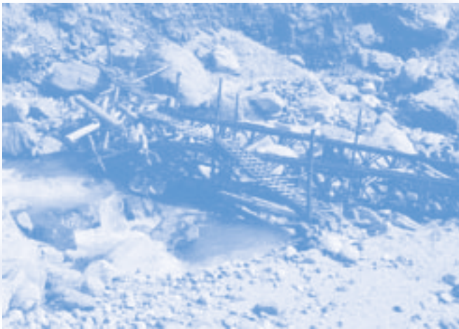
Imagen 1: Puente destruido por alud de rocas. Fuente: Lee Tianchi, 2002
