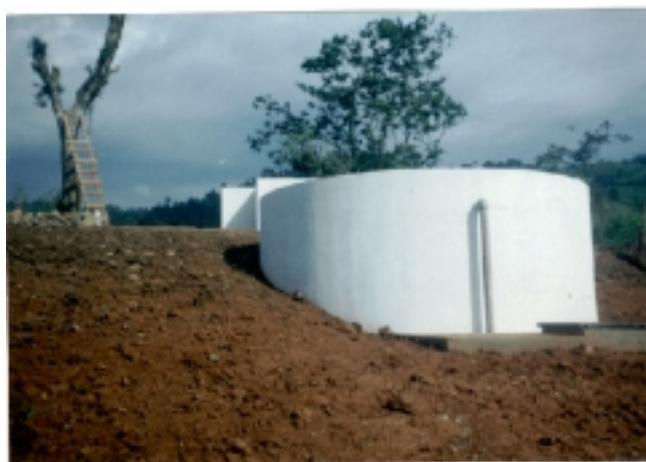
Foto 16. Tanque de reserva sin protección
