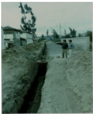
Foto 8. Alcantarillado en construcción en zona rural - Fuente MIDUVI
