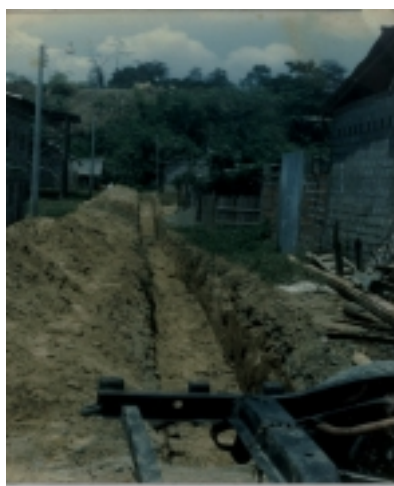
Foto 9. Tendido de tubería de alcantarillado Fuente MIDUVI
