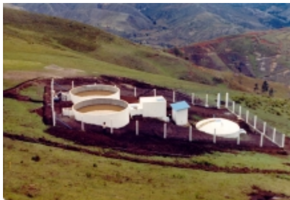
Foto 14. Planta de Tratamiento de ferrocemento
