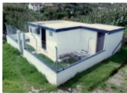
Foto 7. Planta de Tratamiento
