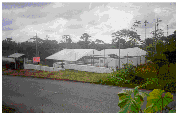
Foto 15. Planta de Tratamiento protegida por caída de ceniza – Fuente MIDUVI
