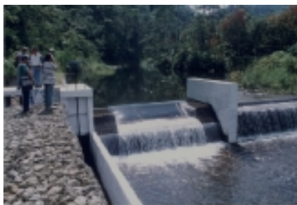
Foto 6. Captación en río
