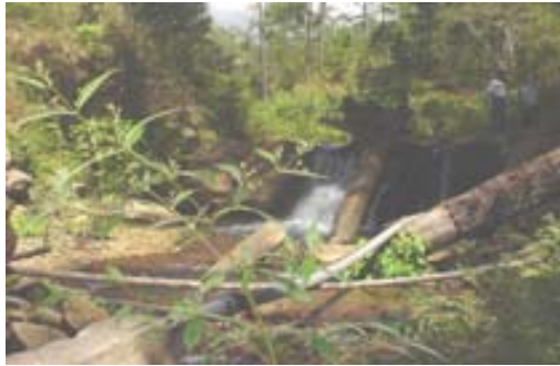
Foto No. 1 Destrucción de presas.
