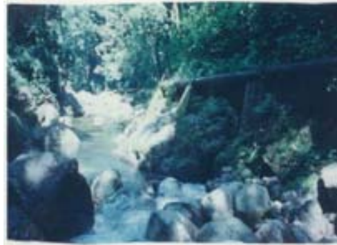
Foto No. 5 Desmoronamiento de taludes
