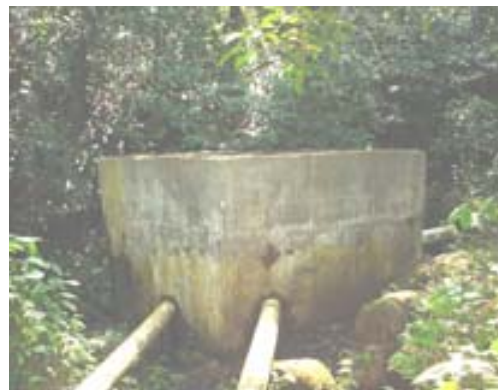
Foto No. 13 Juntas de PVC al desarenador
