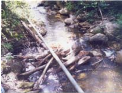
Foto No. 4 tubería destruida en cruces de quebradas y ríos
