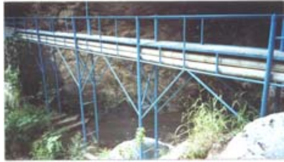
Foto No.4 Protección de tubería de conducción
