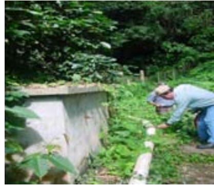
Foto No.5 Tubería expuesta
