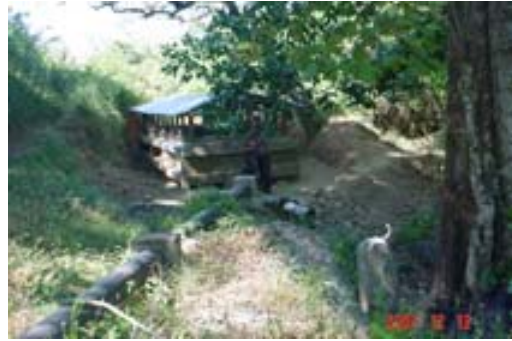
Foto No. 5 Protección del desarenador, presa Guanacaure
