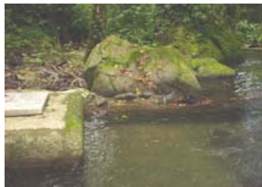
Foto No.6 Caja en la Obra de toma
