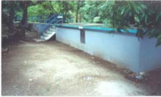
Foto No.3 Desarenador
