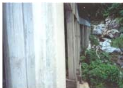
Foto No.2 Línea de conducción
