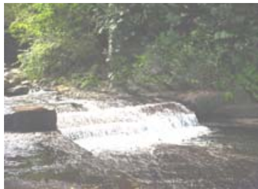
Foto No.4 Obra de toma
