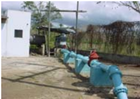
Foto No.3 Protección de tubería
