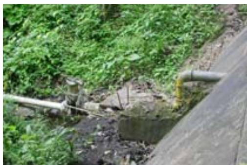
Foto No.1 Anclaje en obra de toma
