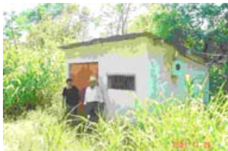
Foto No.1 Caseta de bombeo.
