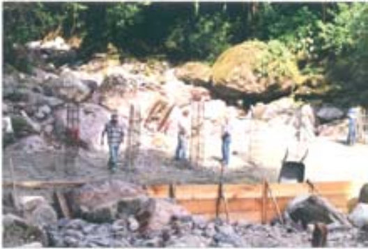
Foto No. 5 Construcción de Toma
