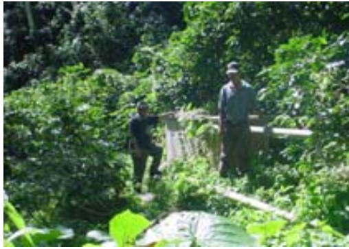
Foto No.4 tubería expuesta
