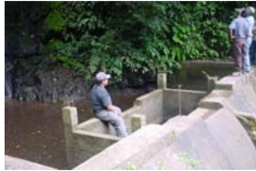
Foto No.2 Obra de toma
