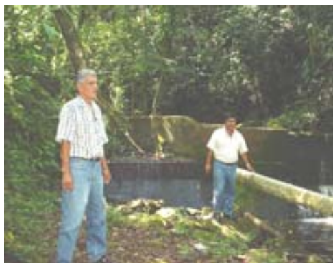
Foto No.4 Obra de Captación
