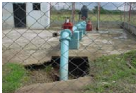
Foto No.5 Tubería de conducción
