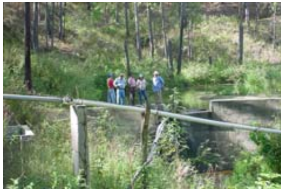
Foto No.1 Obra de Toma
