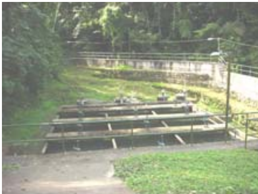
Foto No.1 Obra de toma
