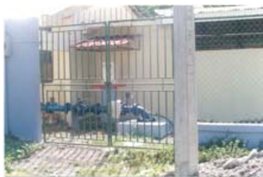
Foto No.6 Protección de pozo
