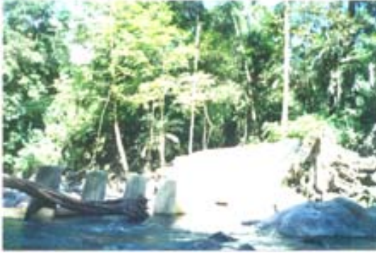
Foto No. 3 Destrucción de toma
