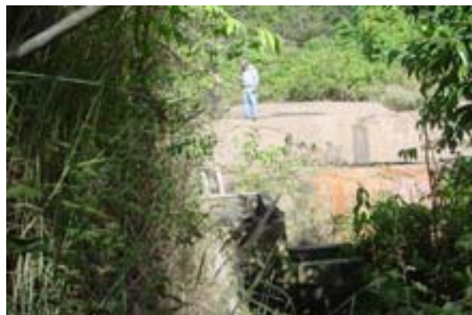
Foto No.3 Nueva obra de toma
