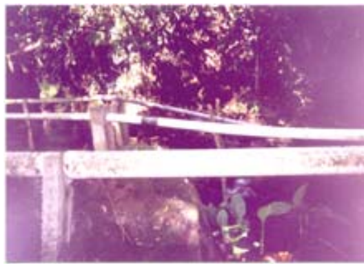
Foto No.2 Tubería de Conducción
