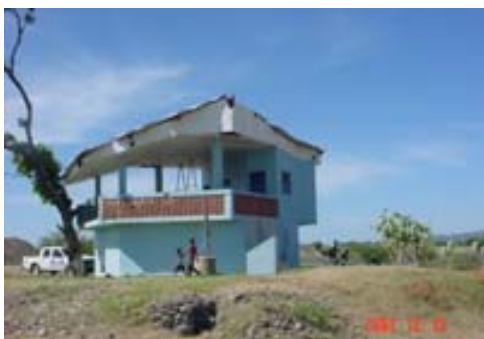
Foto No. 3 Casa de Bombas, Galería de Infiltración.
