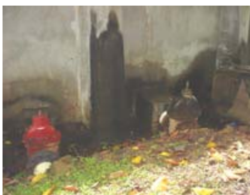
Foto No. 3 Válvula expuesta.
