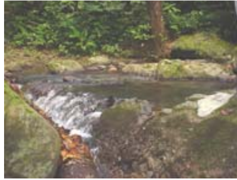
Foto No. 4 Destrucción de la toma
