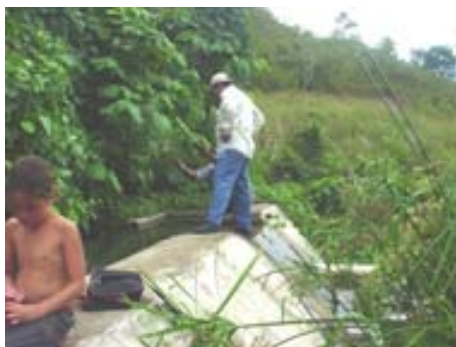
Foto No.2 Obra de Toma
