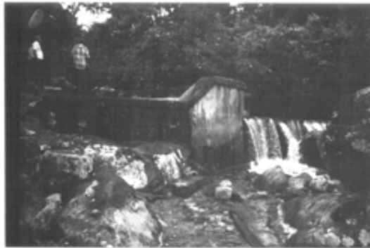
Foto No.1 Obra de toma
