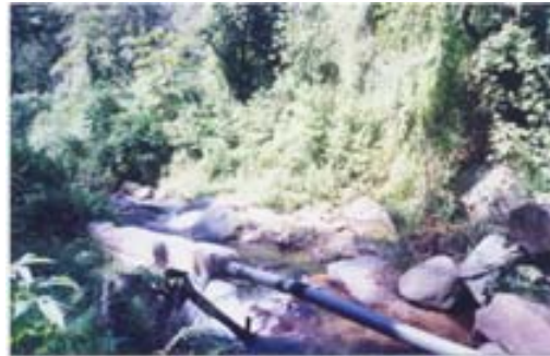
Foto No.2 Anclajes de la tubería
