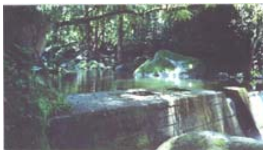
Foto No.1 Obra de Toma
