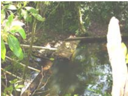
Foto No.1 Obra de captación
