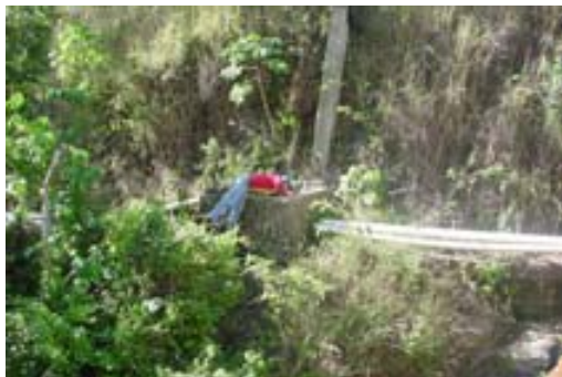
Foto No.4 Tubería expuesta
