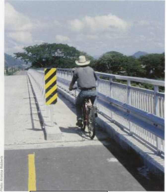
(Arriba) Vista del puente destrozado en Nacaome, en el departamento de Choluteca al sur del país. (Abajo) Detalle del nuevo puente en Nacaome, recién inaugurado y que ahora cuenta con un carril especial para bicicletas y peatones.
