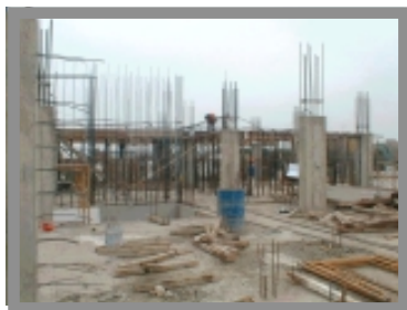
Figura 4 Columnas (sistema de pórticos)
