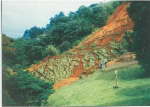
Deslizamiento Cerro Tapezco, Santa Ana 1999.
