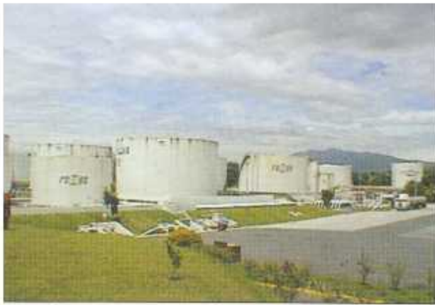
Plantel de Almacenamiento de Combustible - Recope
